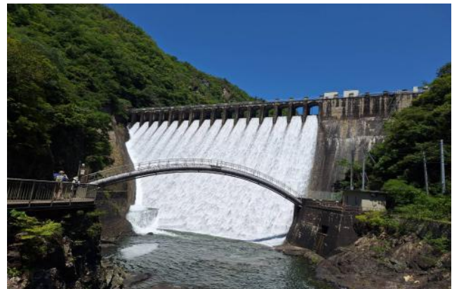
千刈ダム全景
